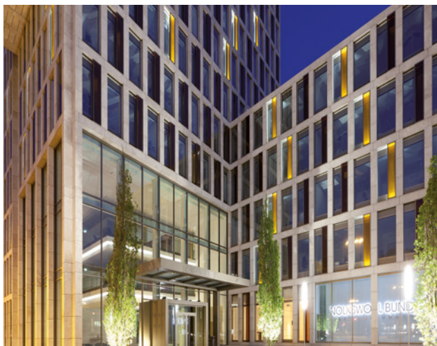
Fassade (linke Seite): CLIMATOP COOL-LITE SKN 165 (3-fach ISO) Fassade (rechte Seite): CLIMATOP PROTECT (3-fach ISO) + STADIP COLOR orange (Paneele)
